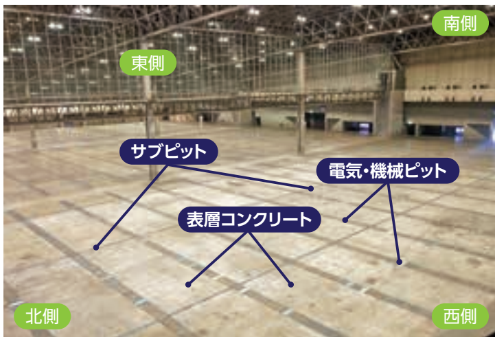
展示ホール床とピット(俯瞰)
